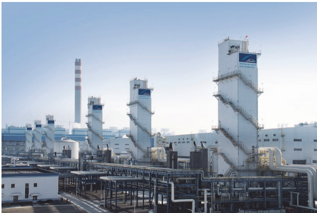
Abb. Luftzerlegungsanlagen bei Yinchuan City, China.
